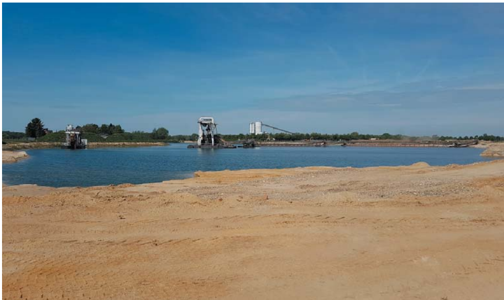
Blick von Osten über den aktuellen Gewinnungssee, links der alte Eimerkettenbagger, Mitte Seilgreifer, Hintergrund die Transportbetonanlage.
